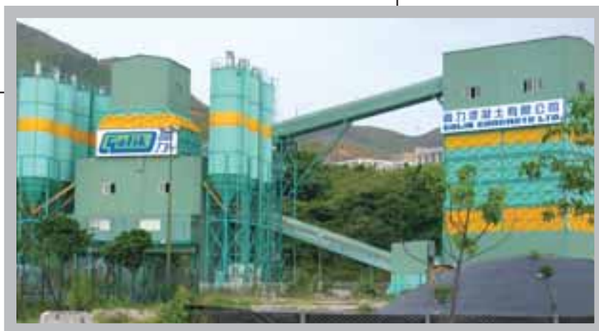
位於香港大嶼山小蠔灣之混凝土廠
